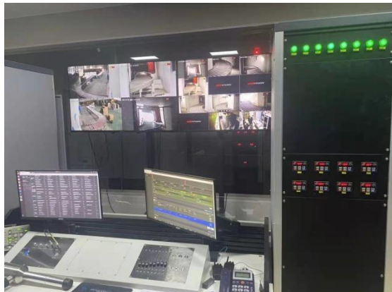
图4-1 辐照电子加速器主控台及监控系统
