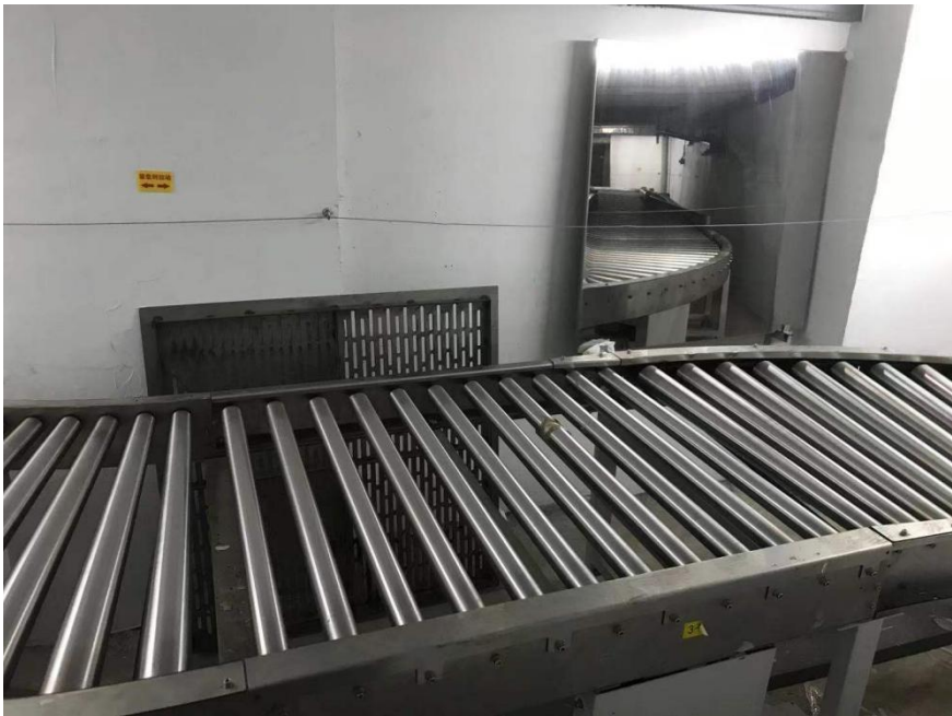
更换下来的不锈钢盖板
